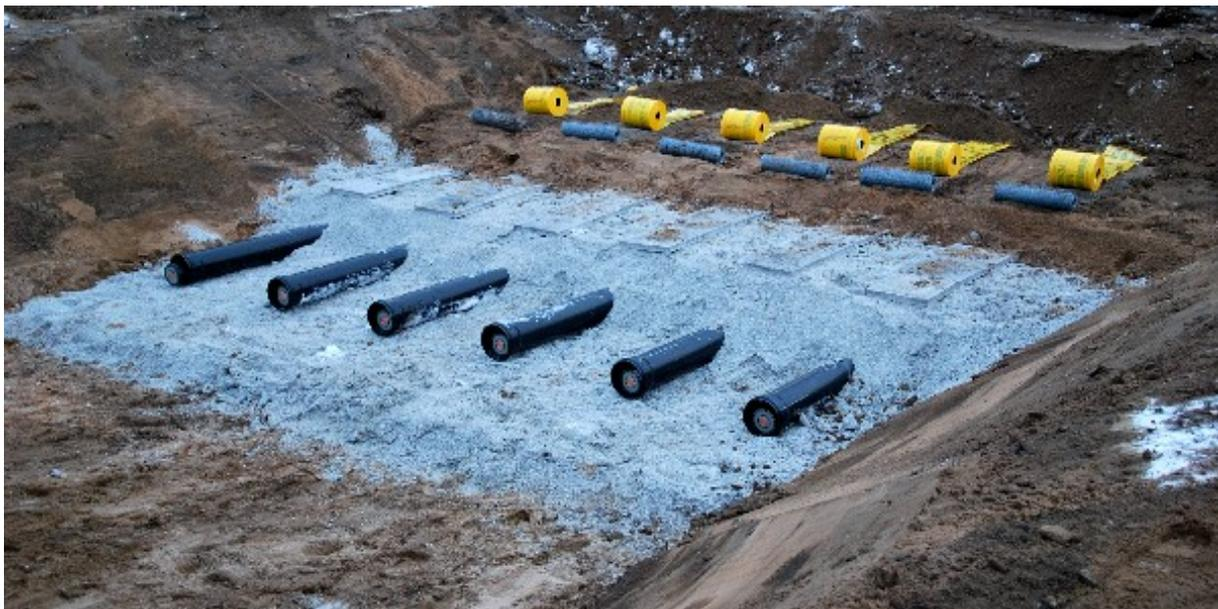
Abbildung 4-6: Kabeltrasse [Amprion GmbH]
