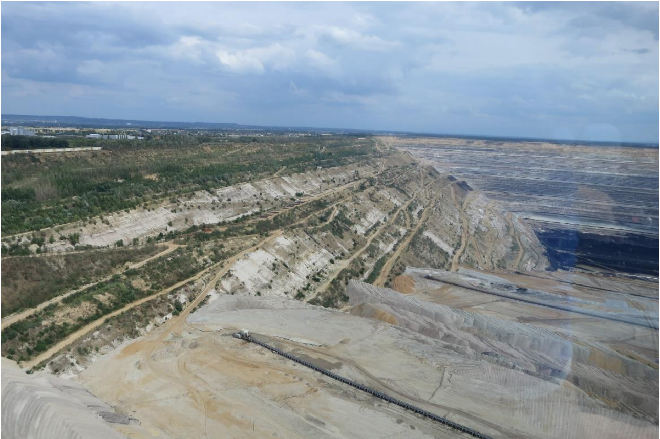
Abbildung 111: Derzeitige Nordböschung bei Elsdorf (1:3,87), im Vordergrund die Innenkippe, im Hintergrund die Hambachböschung (Stand 07.08.2019) 265
