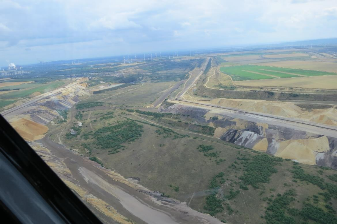
Abbildung 74: Blick von Süden in das östliche Restloch (Stand 7.8.2019) 173 Am linken Bildrand der Damm mit der A44n
