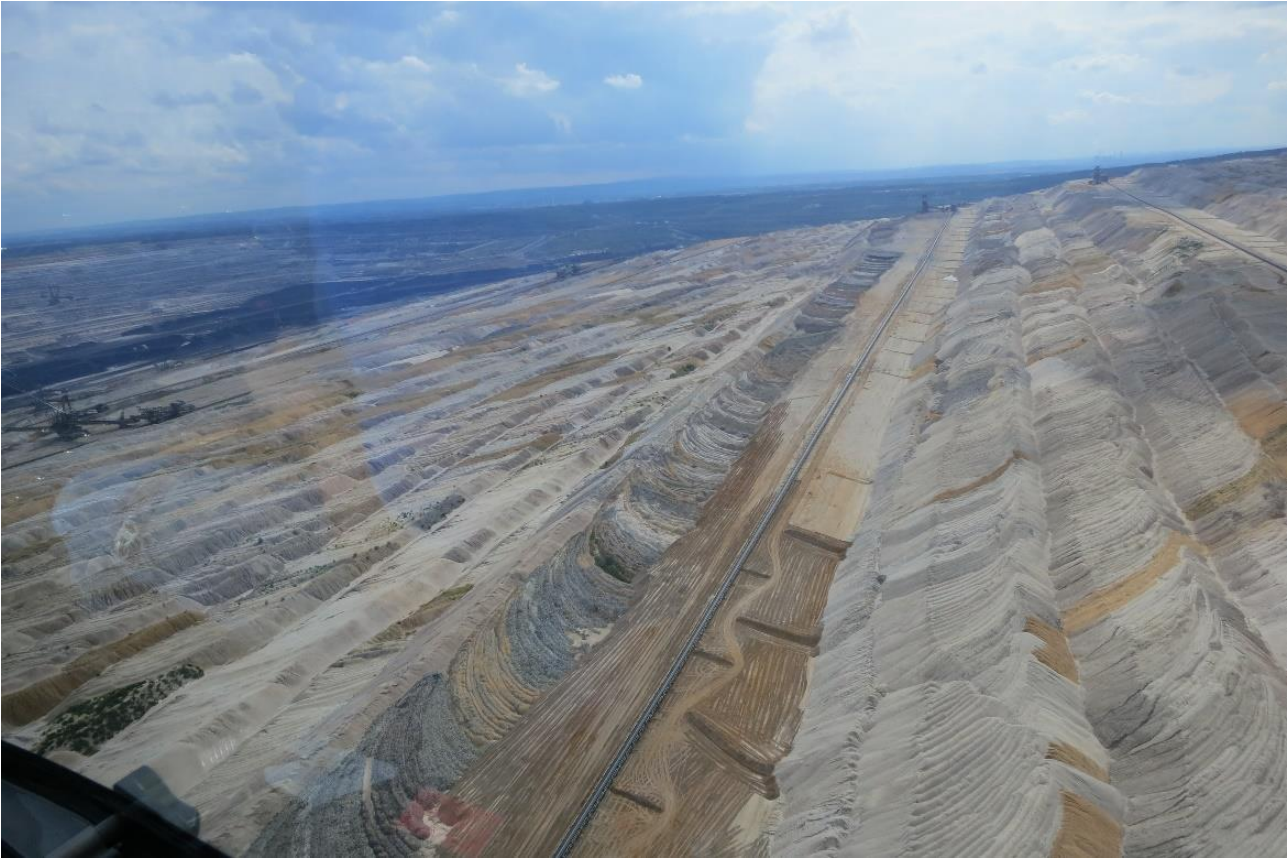
Abbildung 109: Innenkippe in Polderschüttung (Stand 7.8.2019) 264
