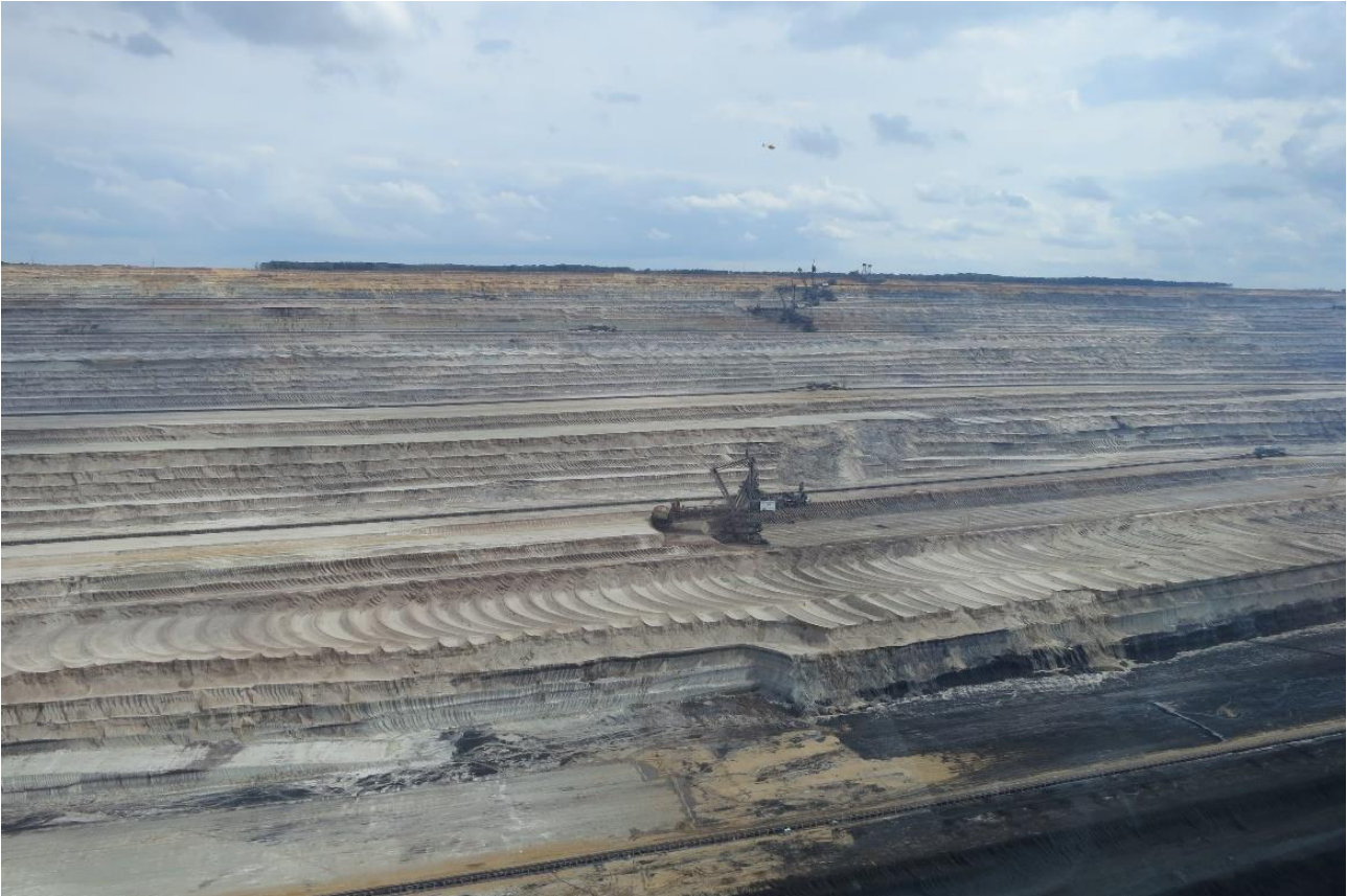
Abbildung 107: Hambachböschung 1:7, im Vordergrund das Tagebaufenster mit der offenliegenden Kohle (Stand 07.08.2019) 262
