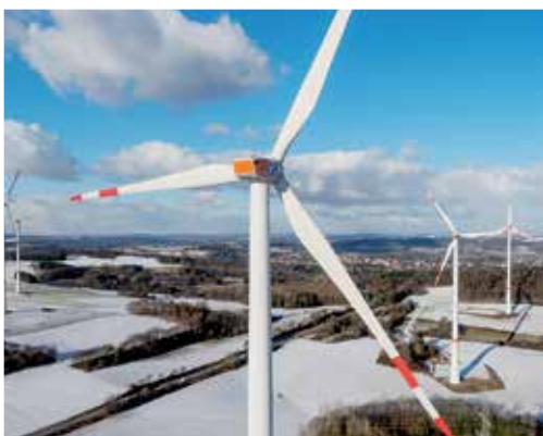
Enovos Windpark in Schiffweiler
