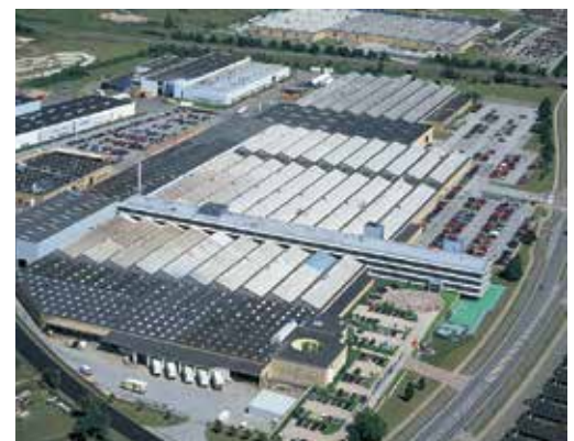
GRUNDFOS Konzernzentrale, Bjerringbro
